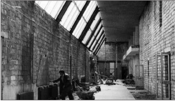
Будівництво спального корпусу санаторію «Карпати» та галереї «зимового саду».
