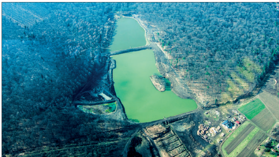
Будівництво відпочинкового комплексу зеленого туризму «Слобода Раковець».
